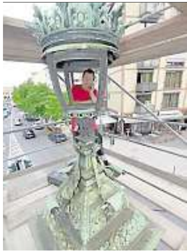
Am 3. Juni 2014 ist das Uhrtürmchen abgebaut worden.
