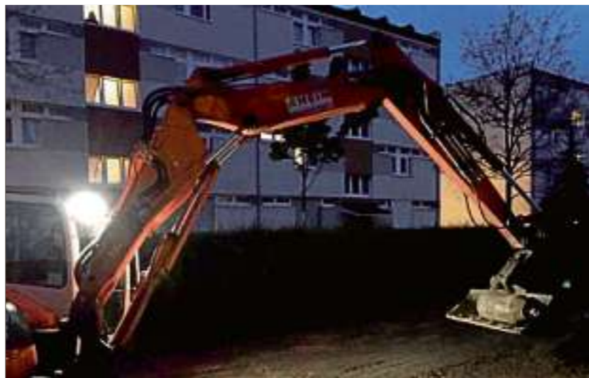
Der Spuk ist vorbei: Ein Bagger hebt die entschärft Bombe hoch, um sie für den Abtransport vorzubereiten. Foto: Polizei Frankfurt
