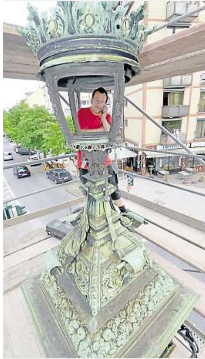
Die Lampe des Uhrtürmchens wurde gestern von Ralf Gerhardt (37) und seinem Team nach und nach abgebaut.
