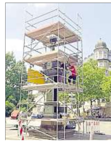
Ein Gerüst hilft das Uhrtürmchen abzubauen. Der Aufbau sorgte für Stau.
