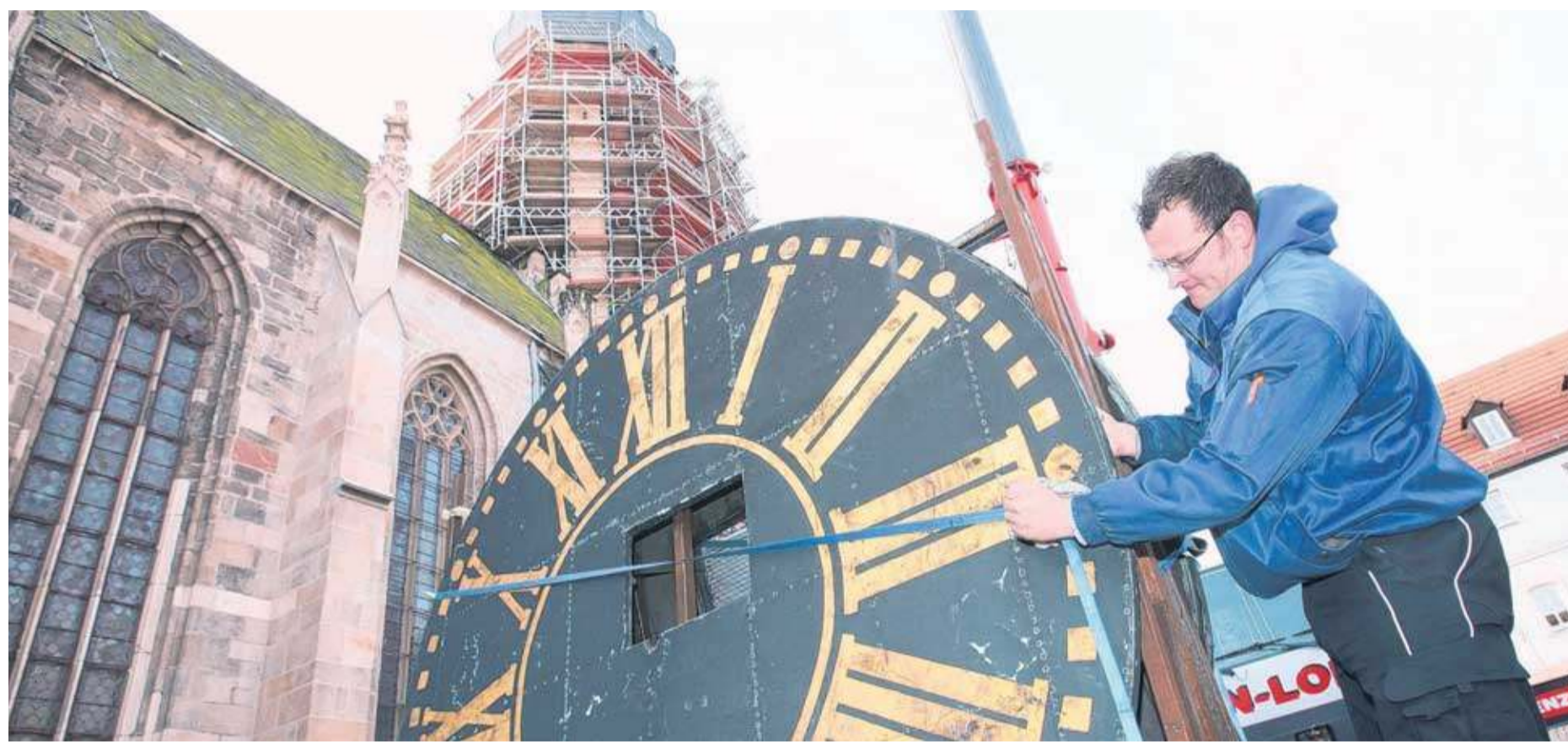
Zeitlos ist seit gestern der Turm der Bartholomäi-Kirche in Altenburg. Kunstschmied Ralf Gerhardt demontiert die Zifferblätter. Auch die Wetterfahne wird abgebaut. Dabei hilft ein schwerer Kran. In den kommenden Wochen sollen die historischen Stücke wieder ihren alten Glanz erhalten. Foto: Mario Jahn
