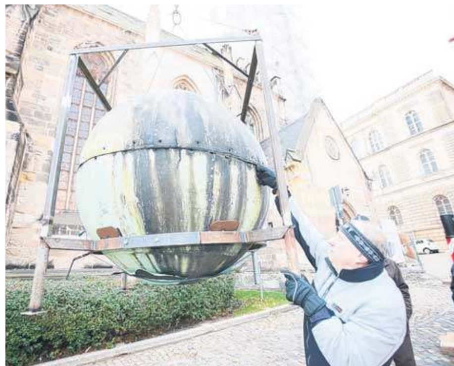
Der Turmknopf mit einem Durchmesser von 1,60 Meter wird in den kommenden zwei Monaten restauriert. Fotos: Mario Jahn
