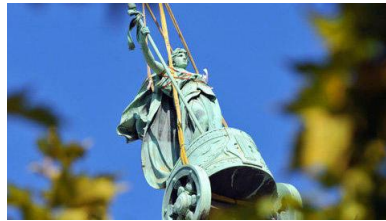
Höhenflug für die Schönheit: Die "Quadriga" wird für Sanierungsarbeiten von der Alten Oper entfernt. Foto: FR/Arnold
