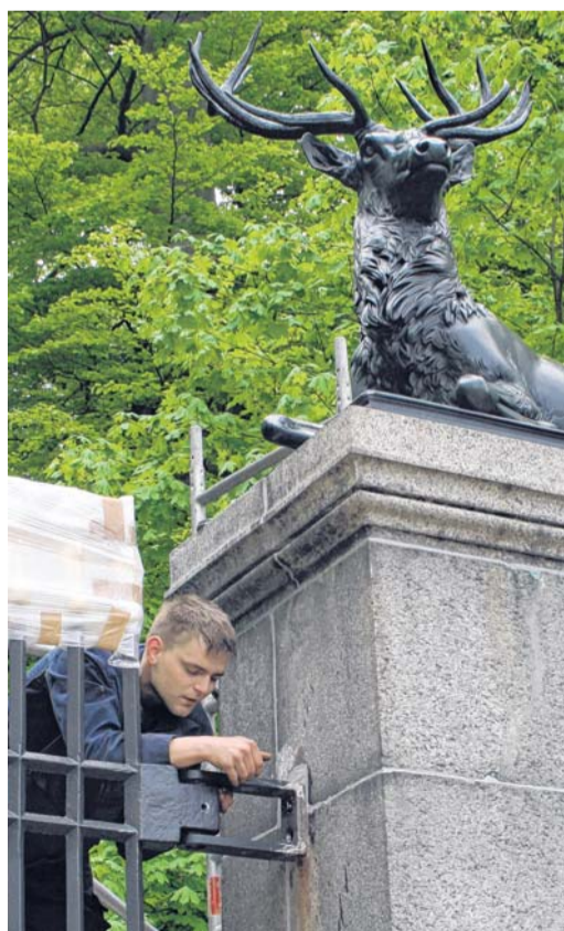
Millimeterarbeit für Vorarbeiter Kurt Oertel: das Einpassen des Tors in die Verankerung
