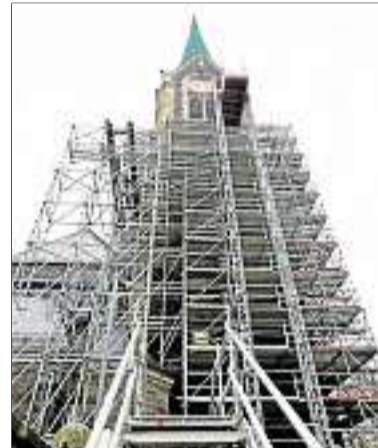
Wie ein Kleid schmiegt sich das Baugerüst an die Peterskirche.
