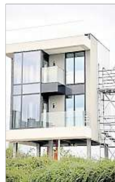
An der Baustelle des „Henninger Turms“ ist eine Musterfassade zu sehen. Foto: Wygoda
